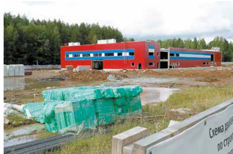
Строительство спортивной школы остановлено
